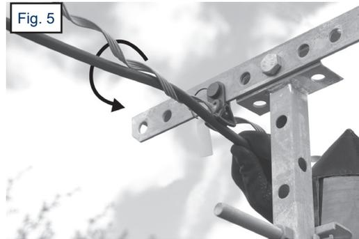
6. Une fois le réglage de la flèche du câble réalisé, terminer d'enrouler les deux branches du spiralé autour du câble.
