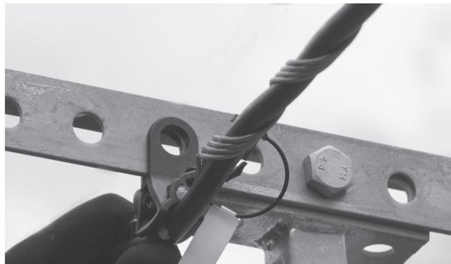
5. Insérer l'axe dans le logement jusqu'en butée.
