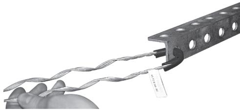
2. Positionner le câble au niveau du repère de peinture de la branche la plus courte puis entourer le câble avec cette même branche sur 1 à 2 tours de façon à retenir le câble à sa tension de pose.
